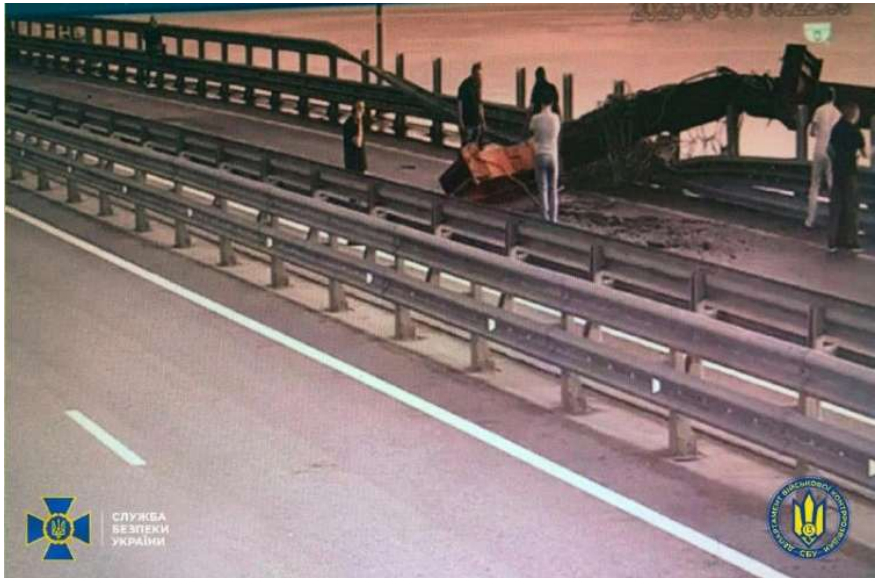
2025年6月3日，乌克兰（Security Service of Ukraine）发布的图片显示克里米亚大桥被炸后，桥面被部分损坏。（乌克兰安全局）
