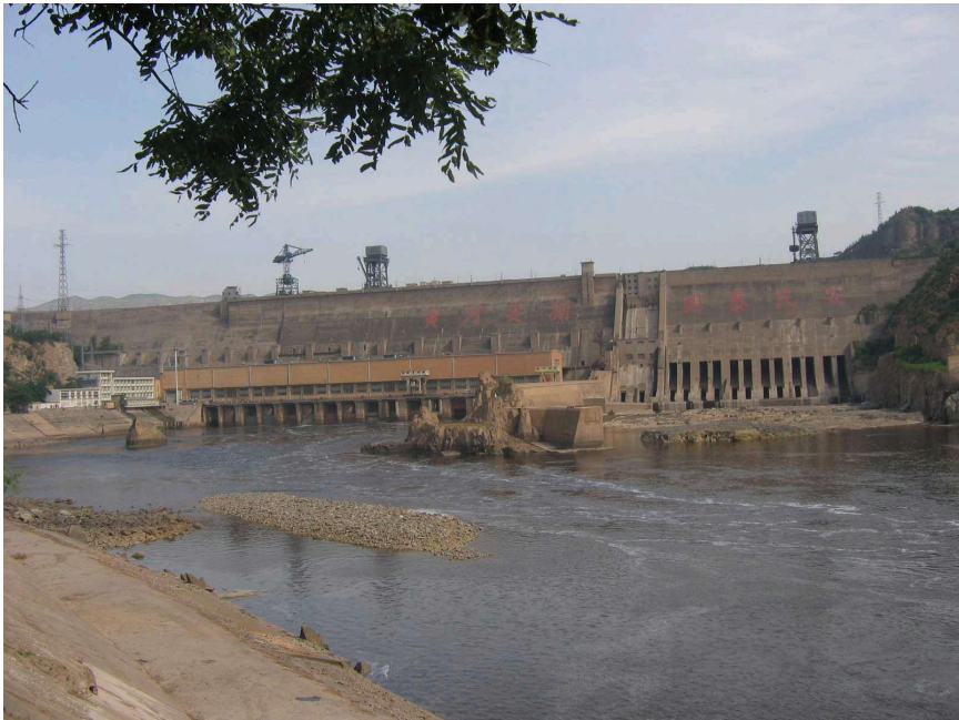
图5：黄河三门峡大坝，大坝依然耸立，但是大量泥沙在水库和上游河道中淤积，仅仅二十年渭河河床平均抬升3至5米，成为地上河，形成巨大的洪水威胁，如今只能采用抽沙清淤的措施延长工程的生命。（公有领域）
