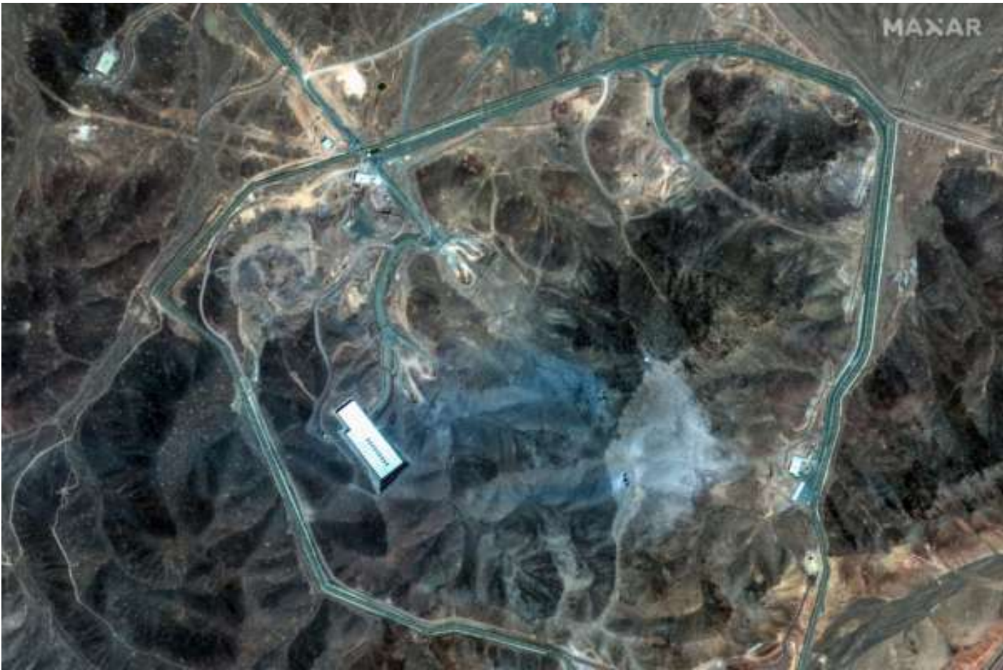
2025年6月22日空袭后，福尔多地下综合体概貌。（卫星图片©2025 Maxar Technologies）
